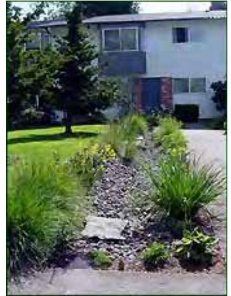
A rock trench
